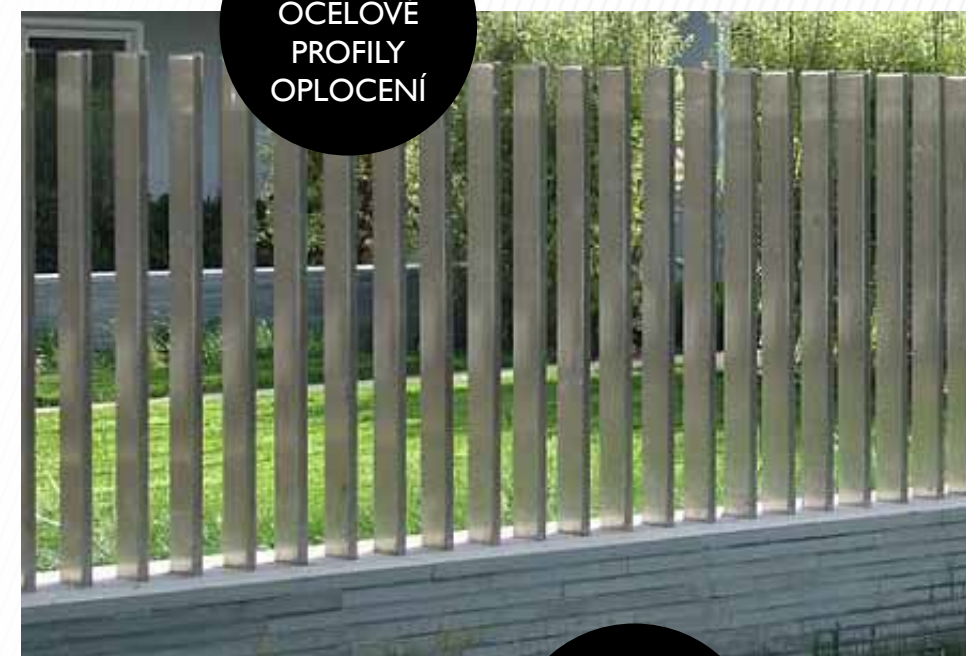
PODEZDÍVKA ZE ŠTÍPANÉHO LOMOVÉHO KAMENE
